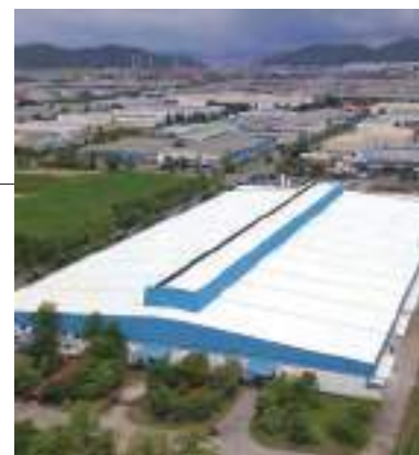
Nowy obiekt Fujitsu General (Tajlandia) Co., Ltd. (Tajlandia) FABRYKA-2
